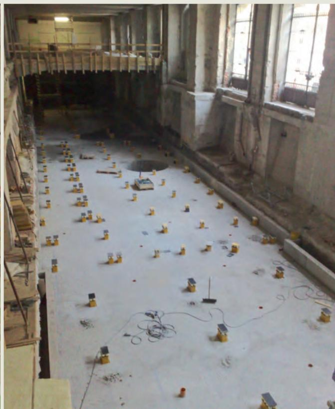
**A SECONDA DELLA POSIZIONE** sono stati utilizzati smorzatori per la sospensione del pavimento di due tipologie costruttive differenti.
