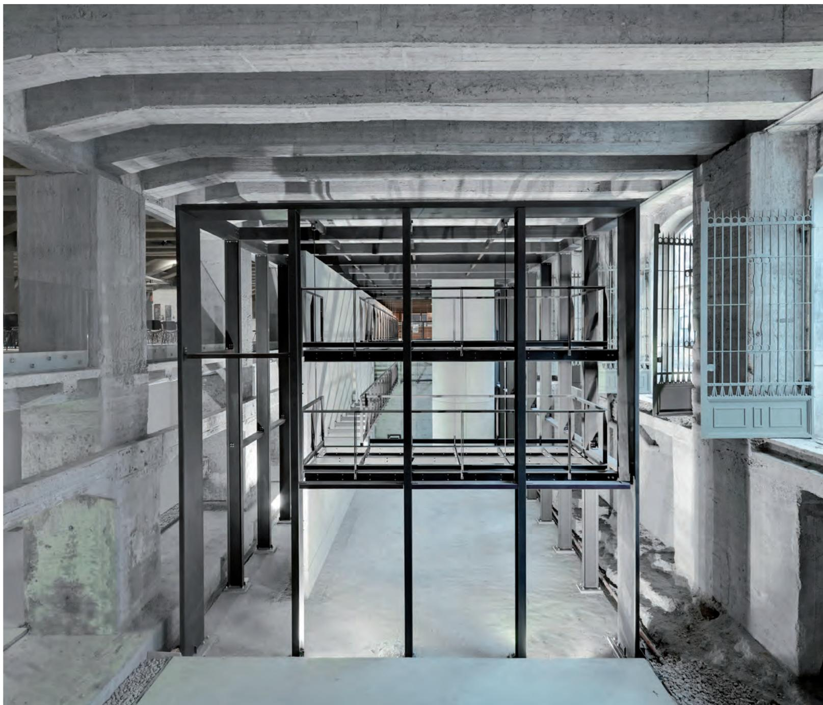
**LA BIBLIOTECA** è stata realizzata come un enorme meccano con struttura in acciaio, demolendo il solaio di copertura del piano interrato lato via Ferrante Apporti. Tutti i giunti metallici della struttura della biblioteca sono leggermente distaccati tra di loro, per meglio denunciare l'aspetto di prefabbricazione dell'opera intera.
