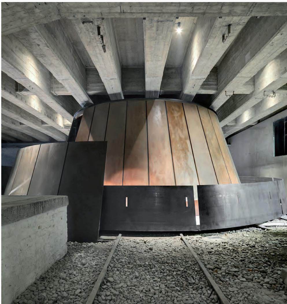
**QUESTO SPAZIO, ORIENTATO A EST**, è desolidarizzato rispetto alle strutture della stazione mediante un basamento inerziale costituito da due solai distaccati mediante smorzatori. La struttura è quindi costituita da un basamento in c.a. che integra la panca circolare interna e una struttura in acciaio rivestita, a guisa di scafo, da due ordini di rivestimenti in pannelli calandrati di acciaio corten acidato, giuntati attraverso speciali piegature e costolature sempre in acciaio.
